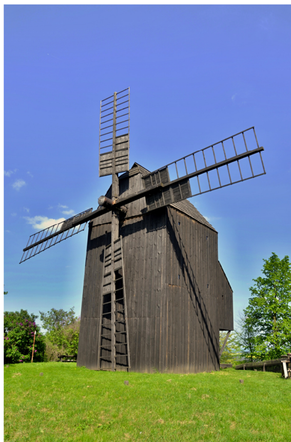
Obr. 20 Větrný mlýn v Kloboukách u Brna (zdroj: vlastní)
