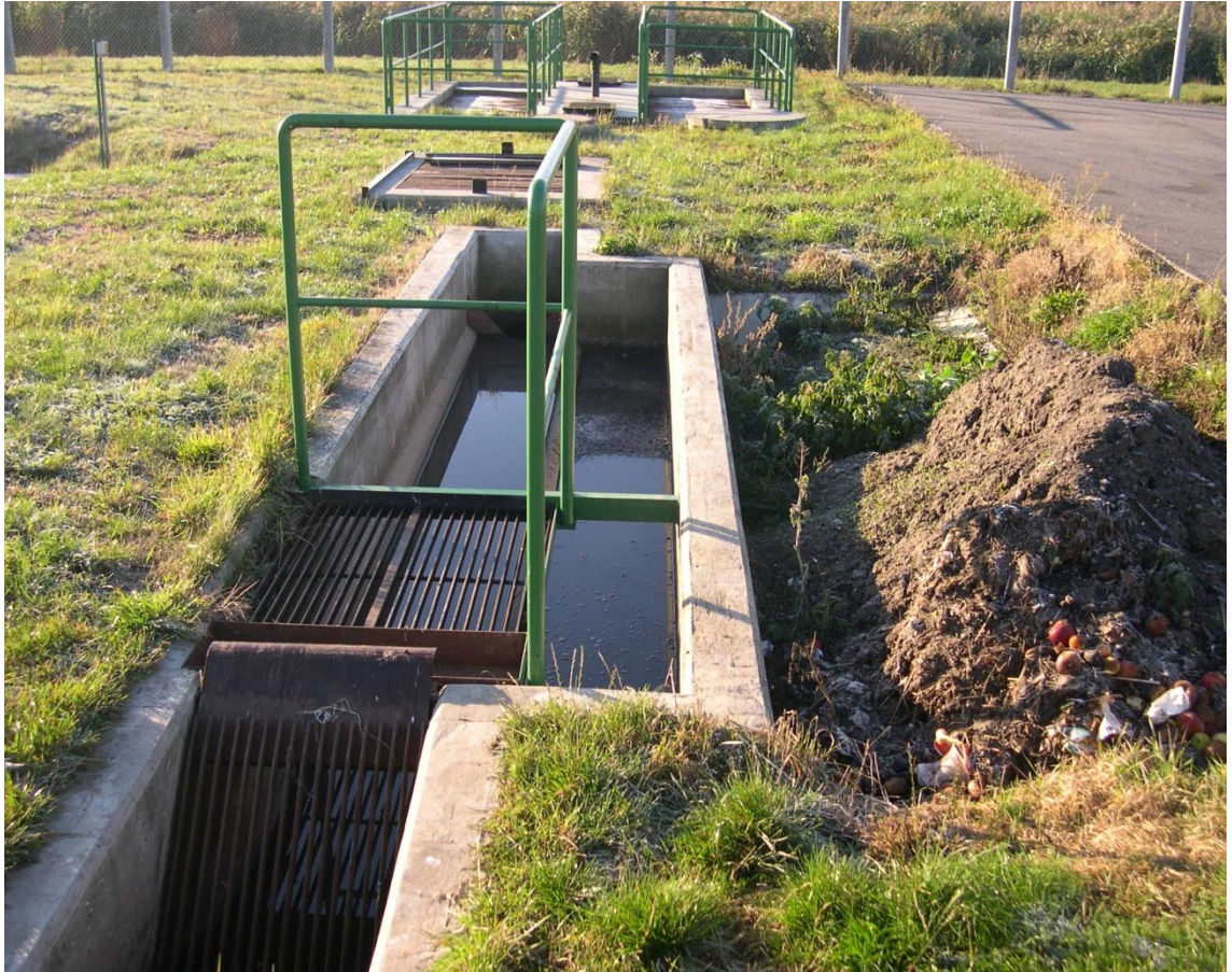
Obr. č. 12. Česle a lapák písku KČOV Machová (Foto: Jan Vymazal).
