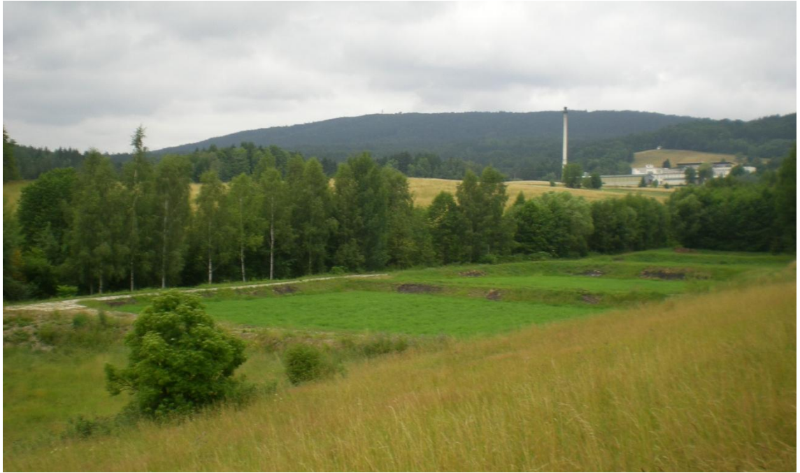
Obr. č. 9. Celkový pohled na KČOV Zásada (Foto: Jan Vymazal).
