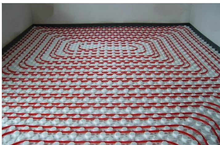
Obrázek 4: Pokládka plastového potrubí – tvorba teplovodních smyček 1
