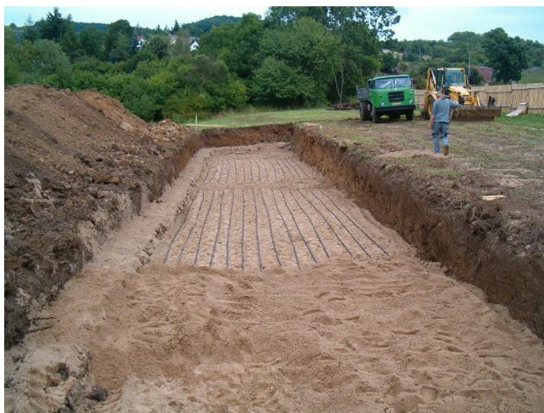
Obrázek 2: Pokládka plošného kolektoru do nezámrazné hloubky 1
