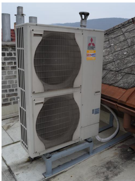
Obrázek 1: Venkovní jednotka tepelného čerpadla vzduch / voda 1 , ukázka strojovny 2
