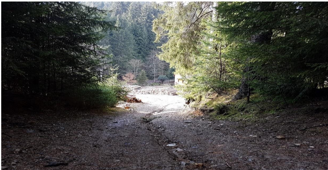
Obr. 16: Povrchový odtok směřující na místa, kde se soustředí dříví (Daniel Sural, 2022)
