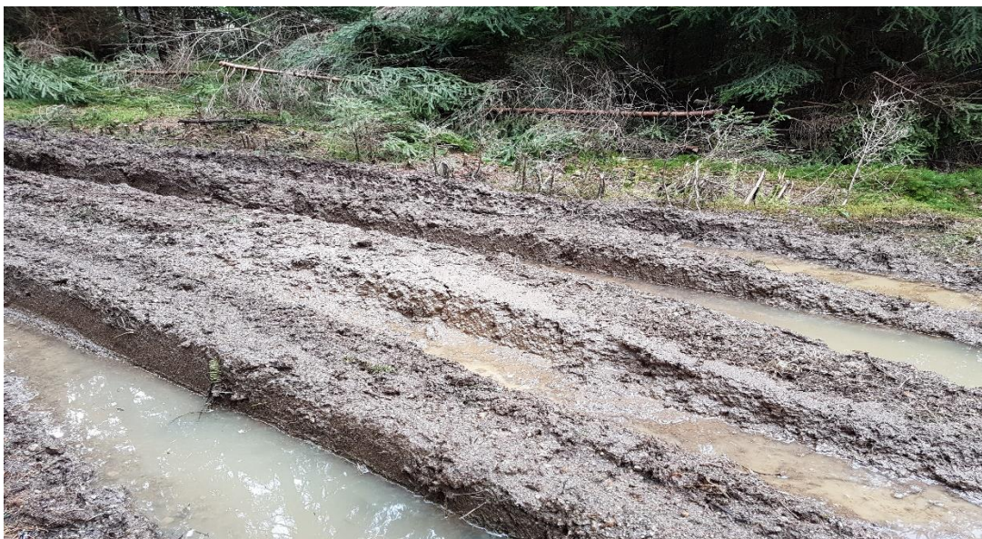
Obr. 22: Lesní cesta poškozená těžkou technikou (Daniel Sural, 2022)
