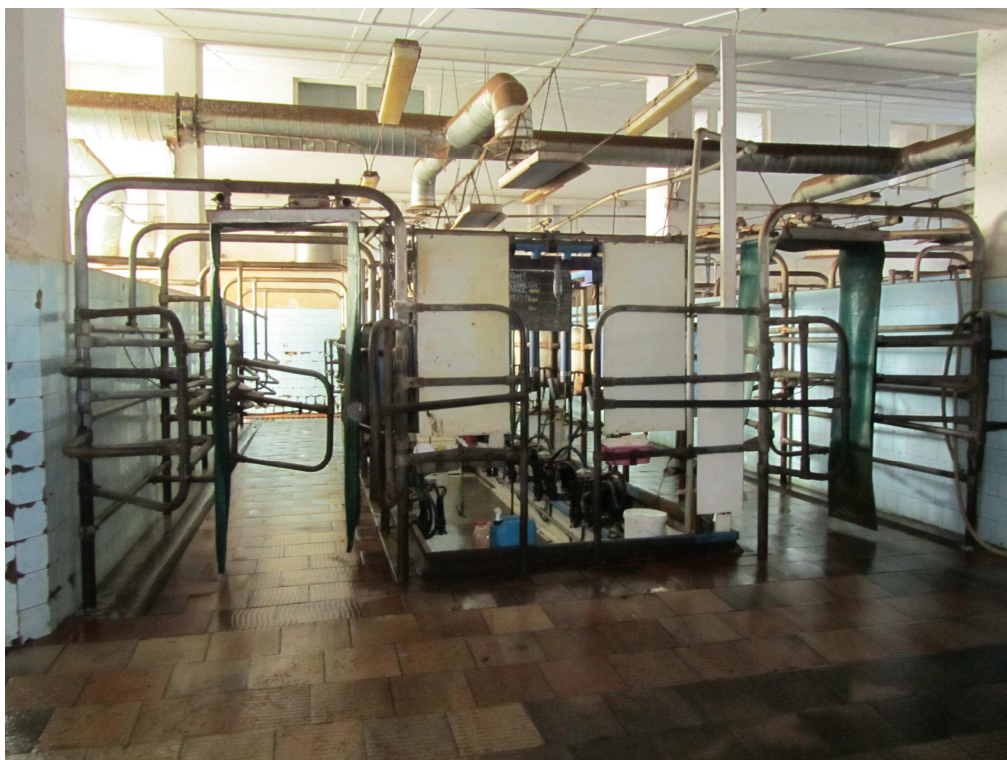
Obrázek 12 - Čekárna. (Zdroj: Jiří Kohout)
