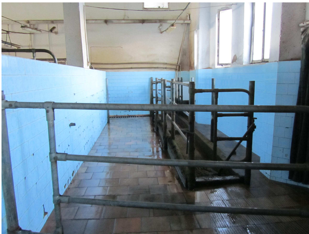
Obrázek 14 - Chodba pro odchod dojníc. (Zdroj: Jiří Kohout)
