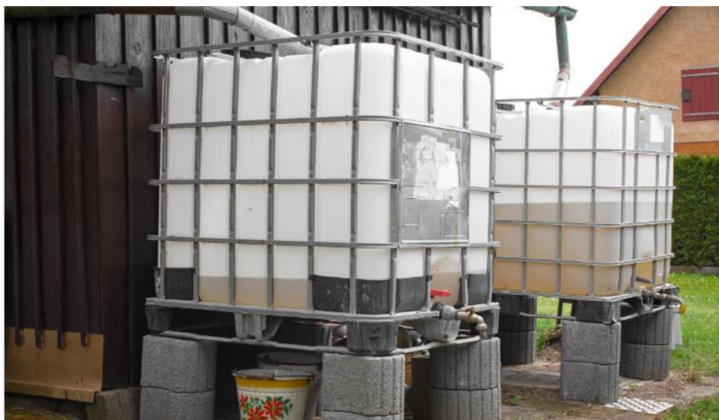
Obrázek 7: Nadzemní nádrže na dešťovou vodu (Green-wiki,2017)
