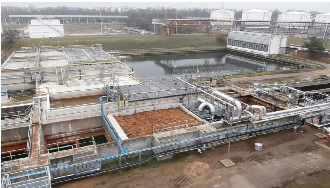
Obrázek 5: ČOV Česká rafinářská, a.s. Kralupy nad Vltavou (Časopis stavebnictví, 2017)
