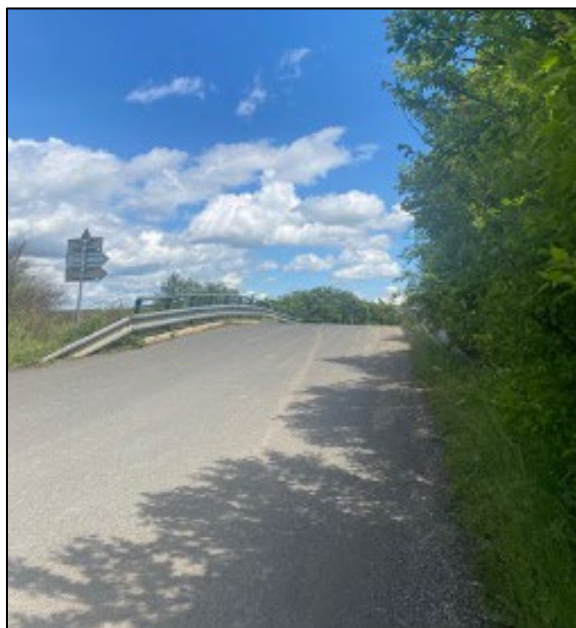
Obr. 23: Most M1 na komunikaci III/0086 (22. 5. 2021)
