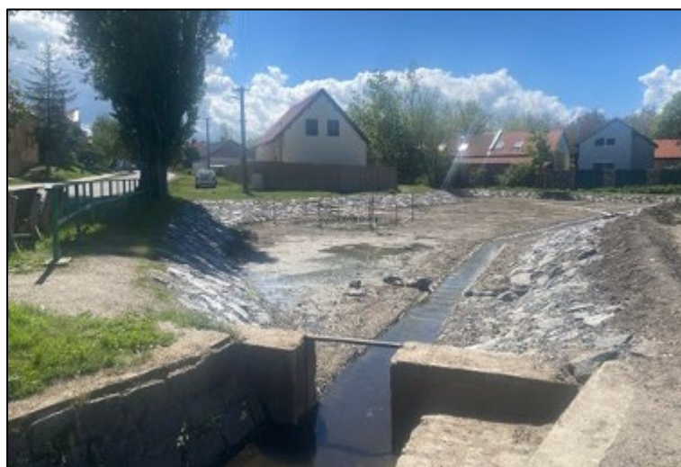
Obr. 16: Probíhající revitalizace obecního rybníku uvnitř intravilánu (22. 5. 2021)
