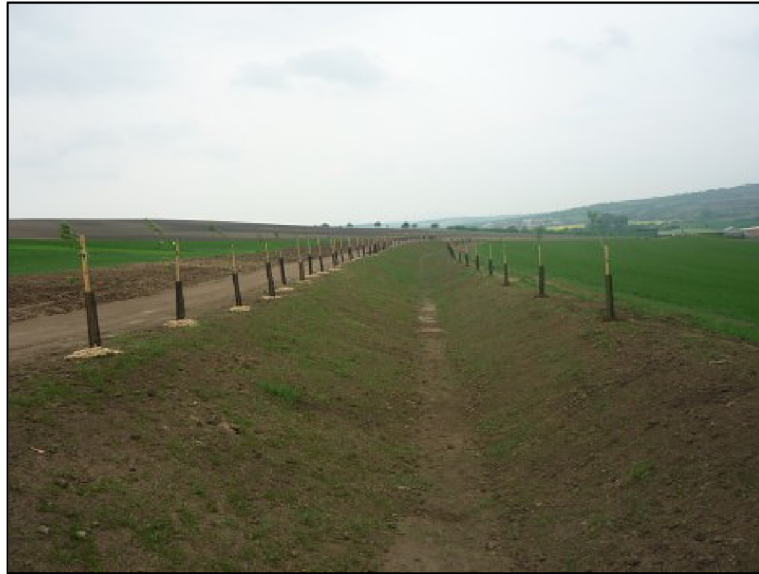
Obr. 4: Ukázka realizace záchytného protierozního příkopu v k. ú. Kobyly (Geomat 2012)
