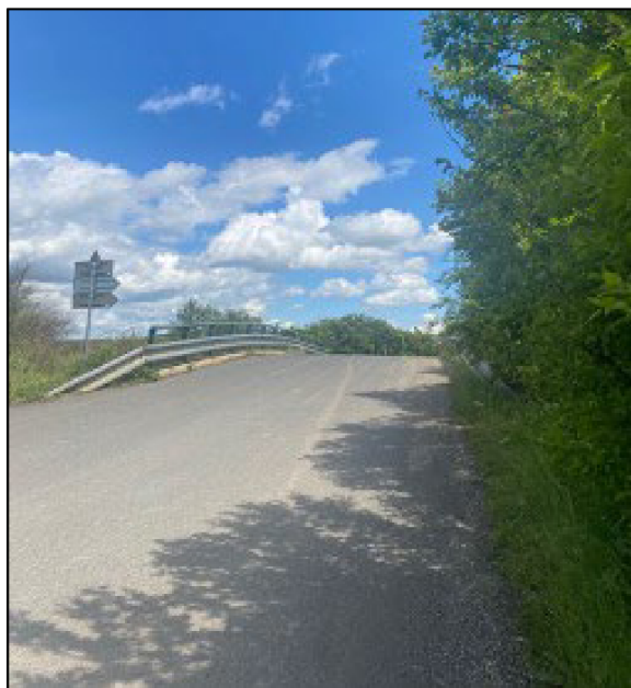
Obr. 23: Most M1 na komunikaci III/0086 (22. 5. 2021)
