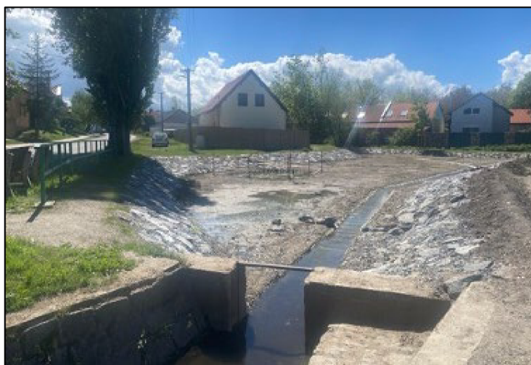
Obr. 16: Probíhající revitalizace obecního rybníku uvnitř intravilánu (22. 5. 2021)
