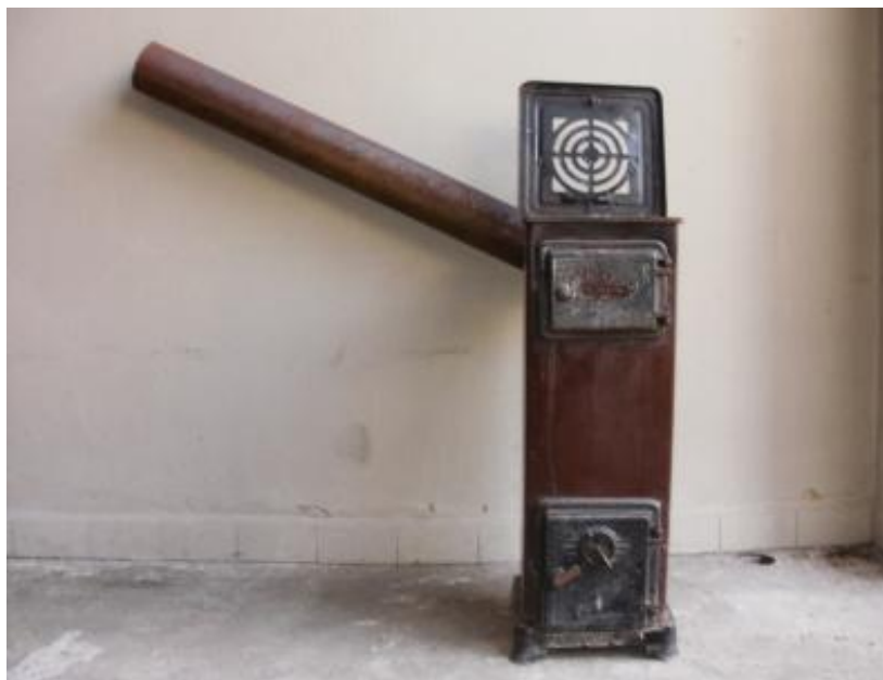
Obrázek č.4 - provizorní spalovací zařízení
