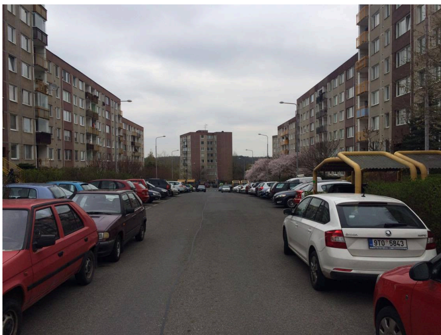
Foto č.1 – Současný stav v ulici Gabinova (Zdroj: Kocábek 2016)
