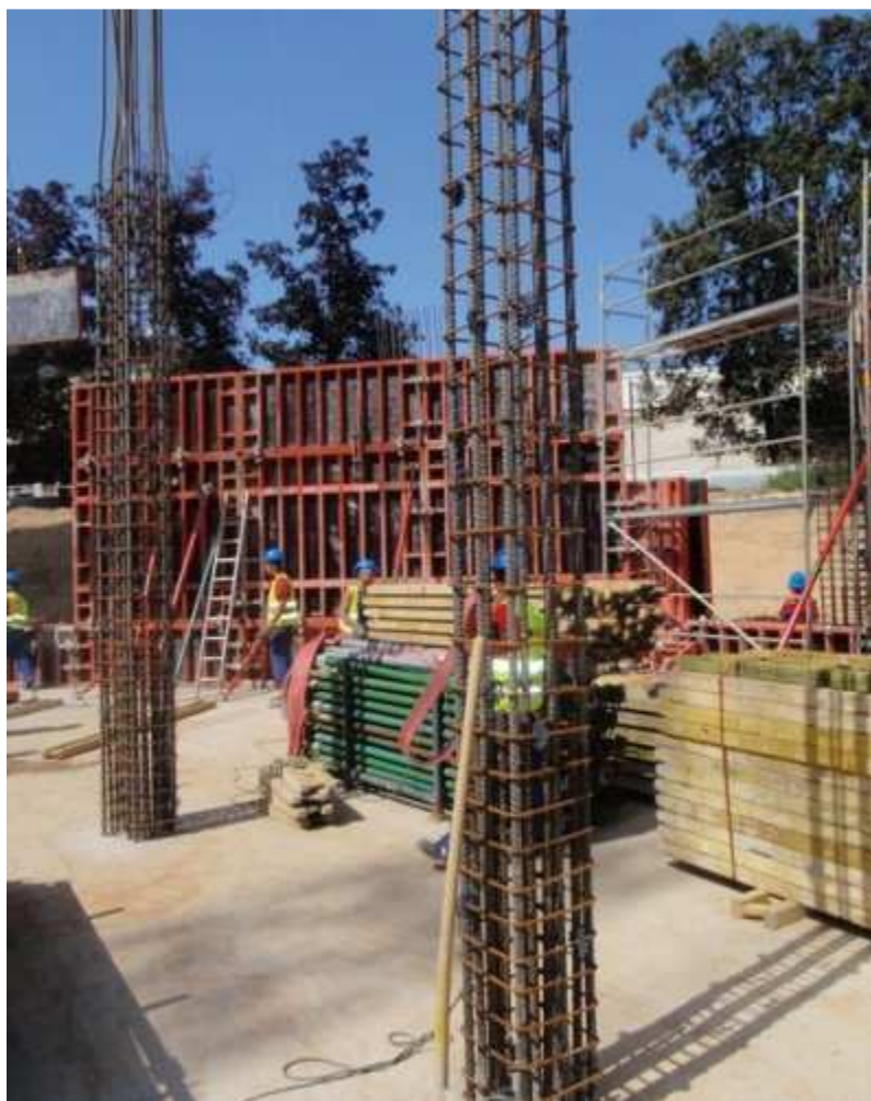
Obrázek 31: Ilustrační znázornění již uložené výztuže sloupů
