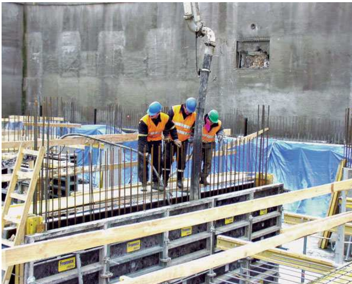
Obrázek 34: Ilustrační zázornění ukládání betonu do bednění za asistence dělníků
