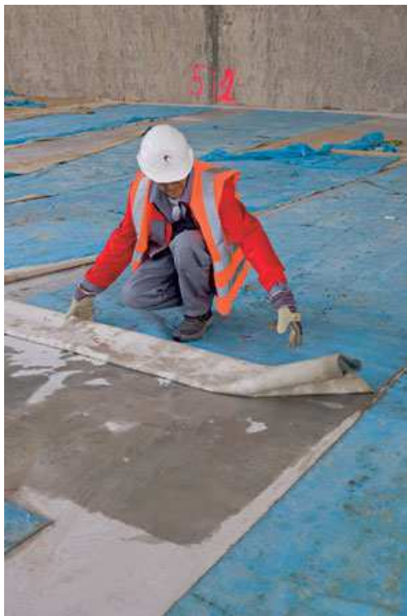
Obrázek 35: Ilustrační znázornění ochrany betonu před vysycháním
