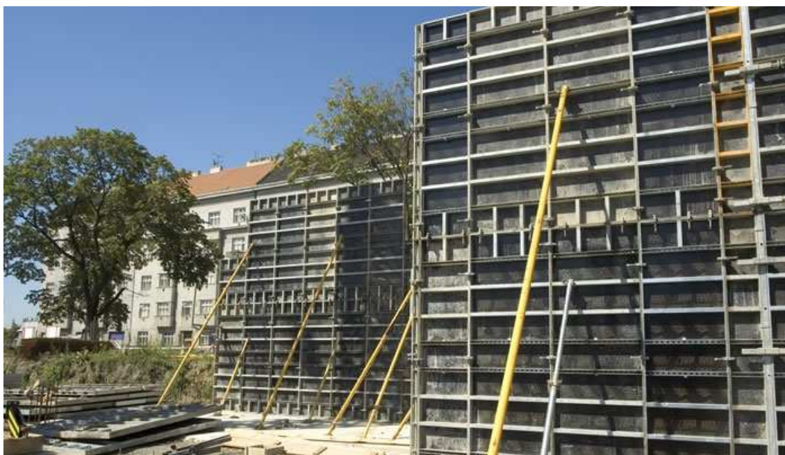
Obrázek 32: Jednostranné bednění LOGIK 50 vytvoří společně s obvodovou vyzdívkou bednění obvodových ztužujících žeber
