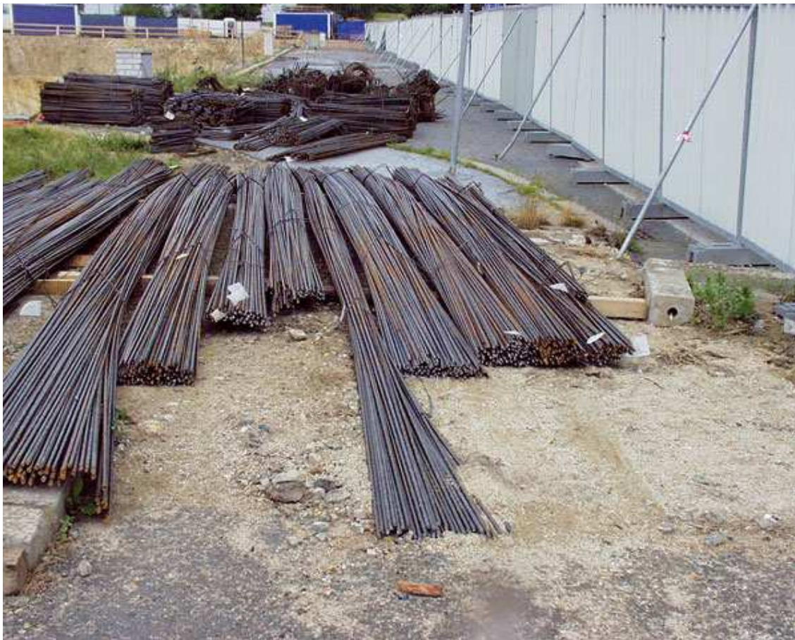
Obrázek 28: Ilustrační znázornění skládky betonářské výztuže
