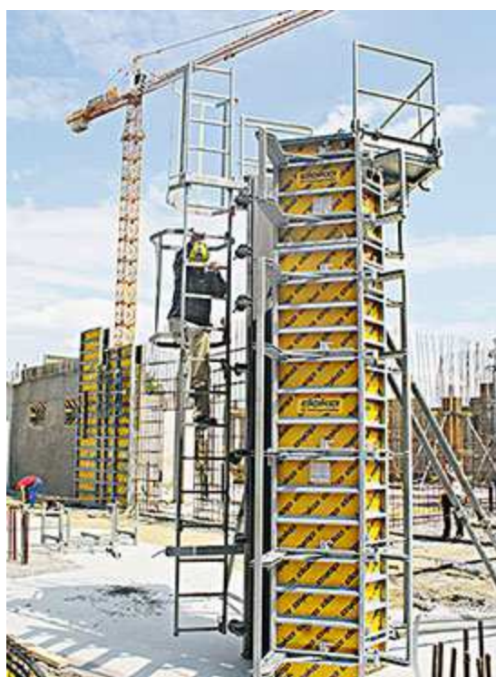
Obrázek 33: Bednění Doka Framax Xlife bude použito pro betonáž vnitřních sloupů
