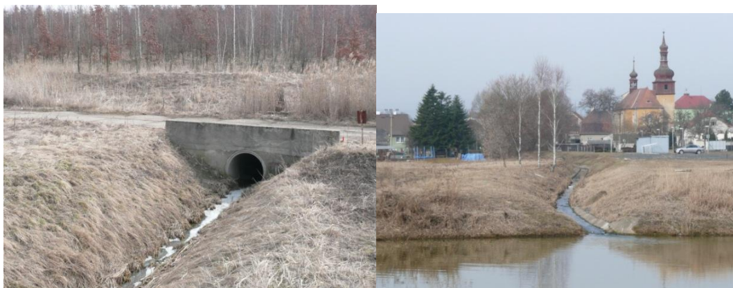
Obr.č. 95,96. na obrázku vlevo odtoková část přeložky řeky Srpiny, vpravo přítok řeky Srpiny do sběrné nádrže od obce Strupčice, (Nestlerová 2011).
