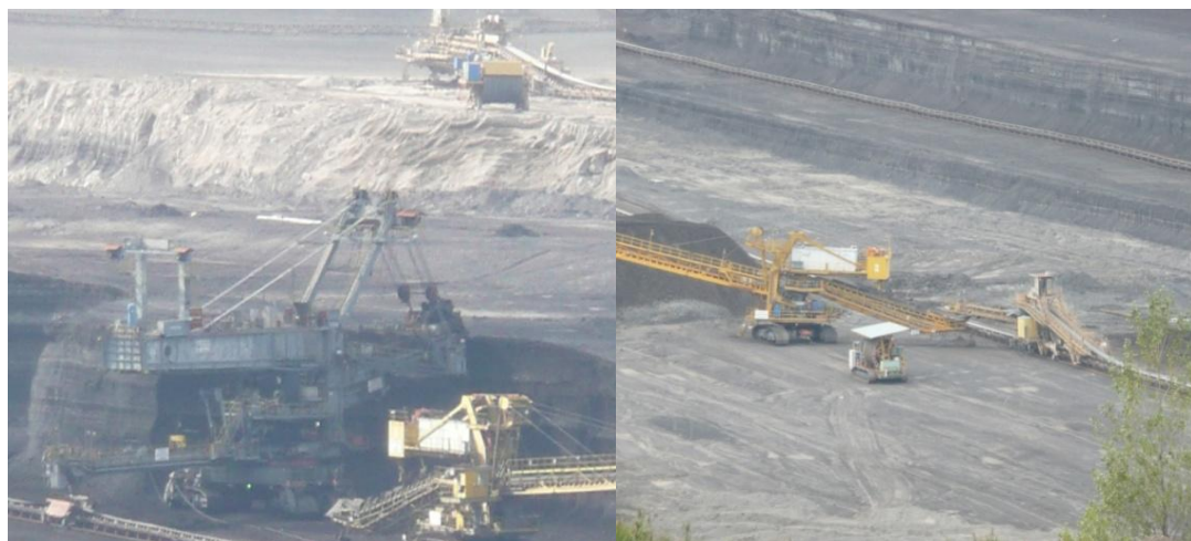
Obr.č.63,64. Současný stav lomu Šverma-Vršany, s velkostroji a pasovými dopravníky na vytěžené uhlí, těžební strana povrchového dolu (Nestlerová 9/2010).
