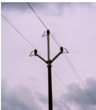
obr. č. 10 - konstrukce typu „Pařát“ (KŘÍŽEK, 2003)
