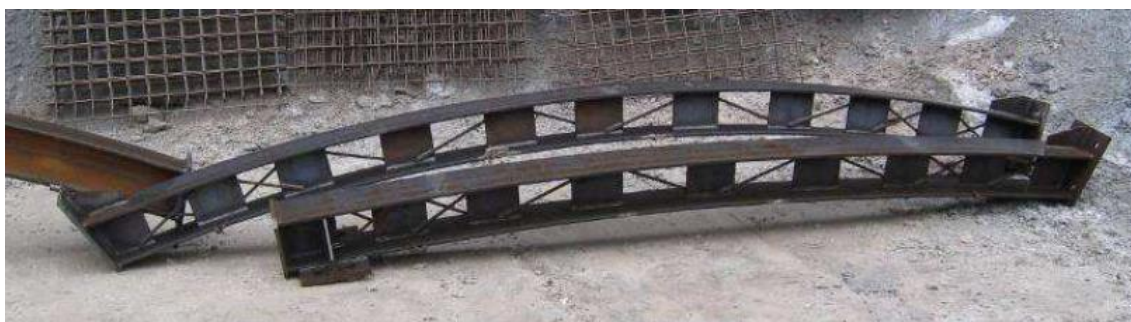
Obr.4-7 Výztužné profily HEBREX z Královopolských tunelů [17]
