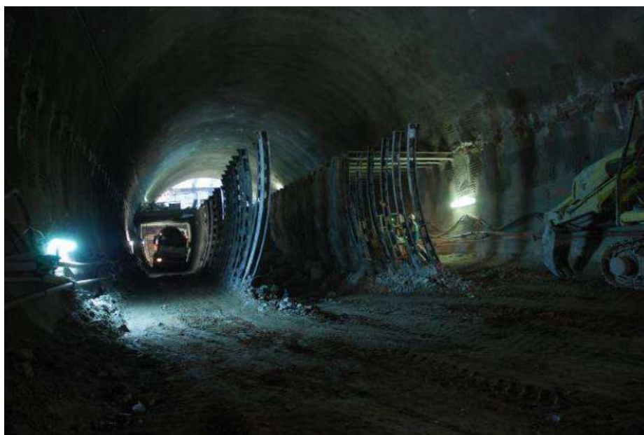
Obr.4-11 Ražba jednoho z Královopolských tunelů – výztuže HEBREX [17]
