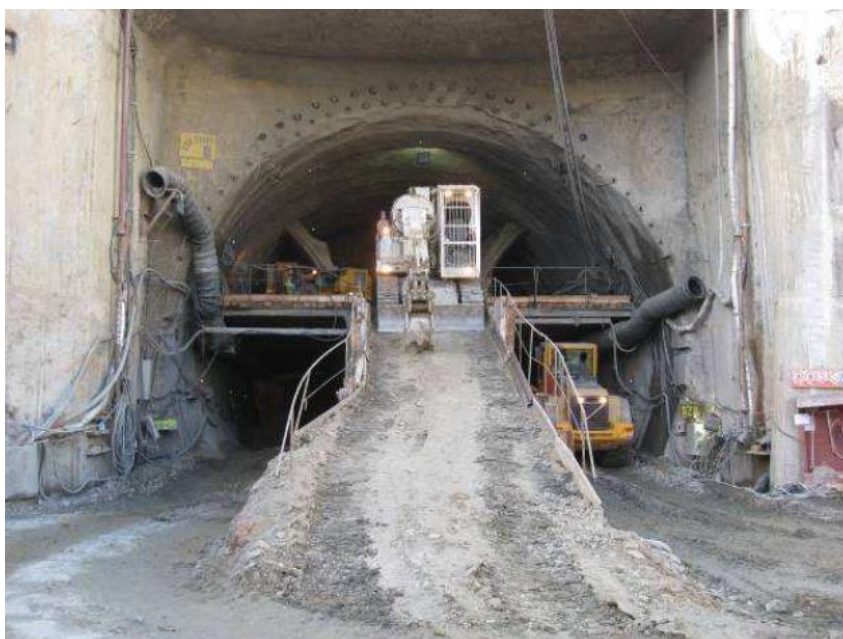
Obr.4-9 Ražba jednoho z Královopolských tunelů - portál [17]
