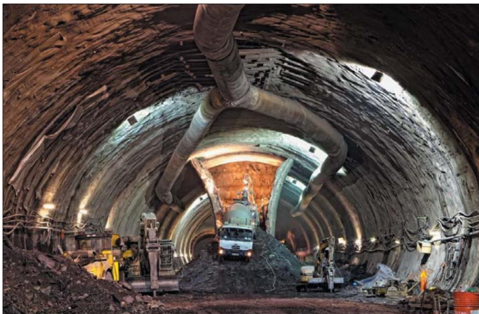
Obr.4-1 Ražba stanice metra pomocí NATM [15]
