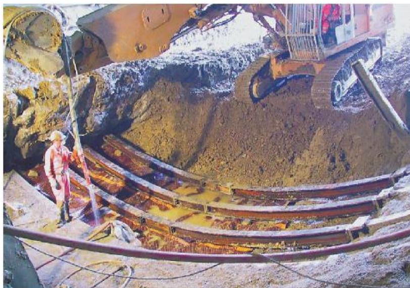
Obr.4-17 Uzavření počvy výrubu tuhými rámy - Uetlibergtunnel [18]
