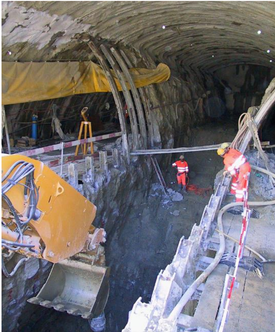
Obr.4-16 Ražba jádra výrubu Uetlibergtunnel [19]
