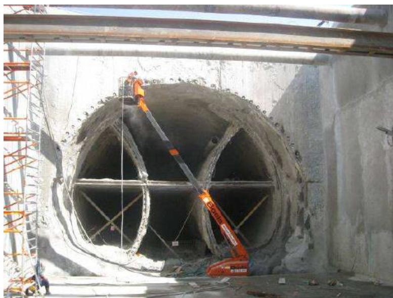
Obr.4-5 Členění jednoho z Královopolských tunelů [17]
