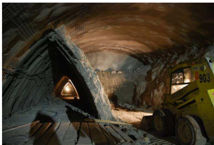
Obr.4-10 Ražba jednoho z Královopolských tunelů – levá horní kaple [17]
