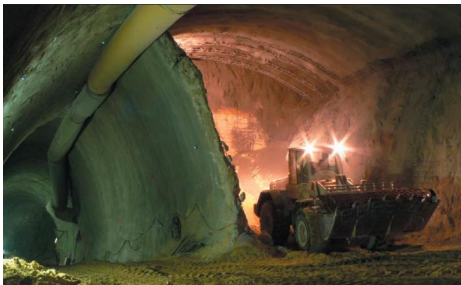
Obr.4-2 Ražba vertikálně členěného výrubu [15]
