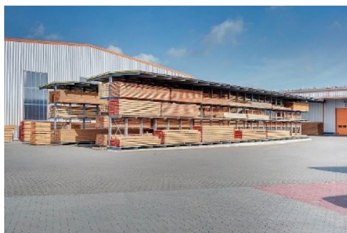
Obr. 1.3 – Venkovní zastřešený sklad
