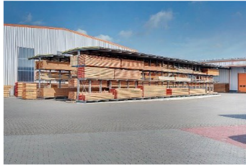
Obr. 1.3 – Venkovní zastřešený sklad
