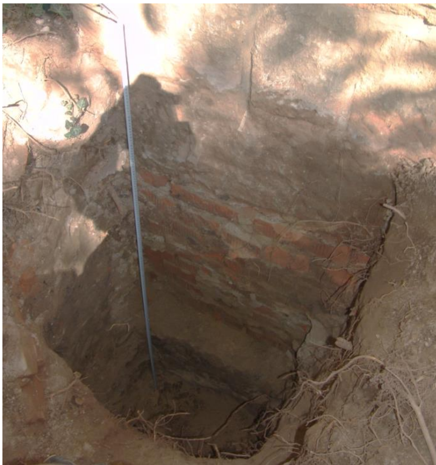
Obrázek 21 - Kopaná základová sonda
