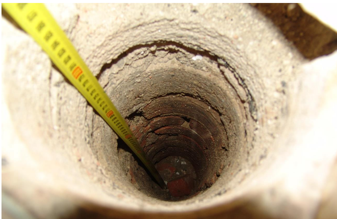
Obrázek 22 - Vrtaná základová sonda
