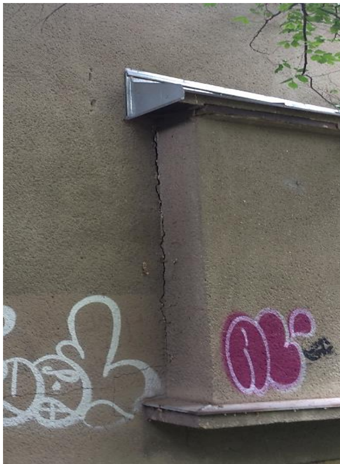
Obrázek 18 - Oddělující se předsazený arkýř od zdiva
