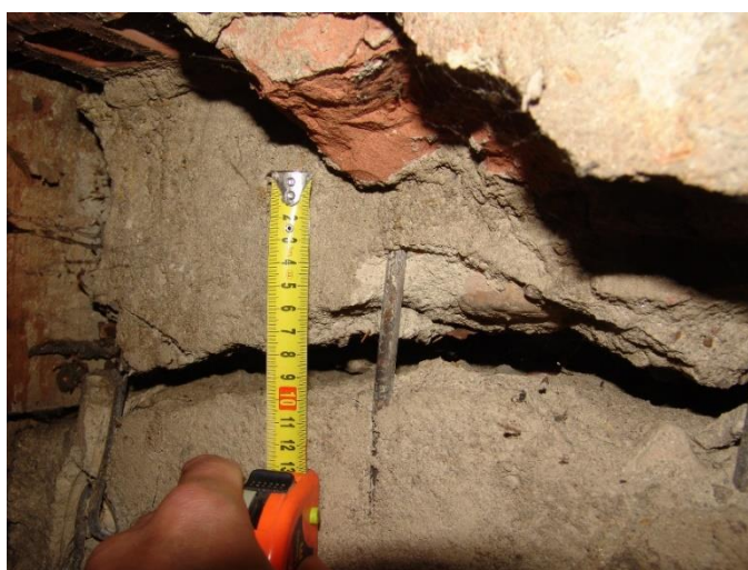
Obrázek 19 - Detail trhliny v obvodovém železobetonovém věnci
