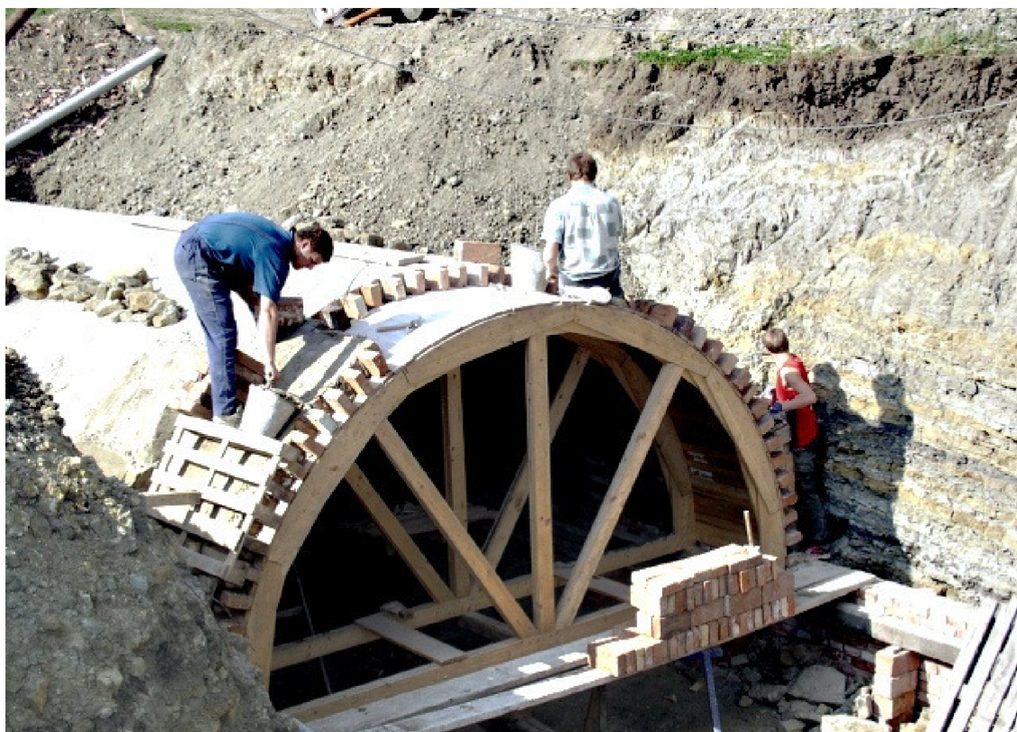
Obr. 4-1 „Kvelbení“ vinného sklepa [13]
