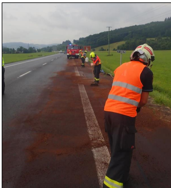
Obr. 74 Zасыпání uniklého paliva přivolanými hasiči při dopravní nehodě mezi Vsetínem a Ústí v roce 2021 Zdroj: Javoříková (2021)
