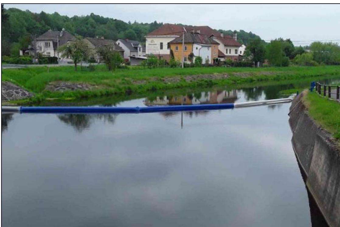
Obr. 79 Norná stěna na řece Bělá v roce 2018 v obci Adolfovice Zdroj: Kamenský (2018), HZS Olomoucký kraj (2018)
