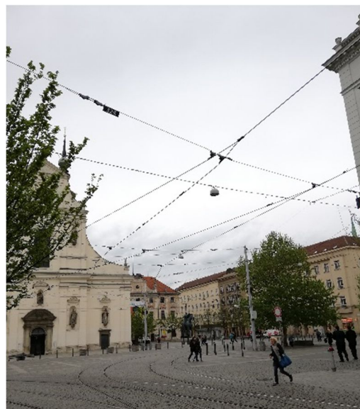
Obr. 24 Trakční systém v Brně, ulice Joštova
