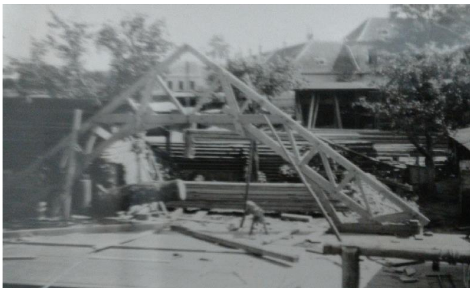
Příloha: 8. Konstrukce krovu s příhradovým nosníkem pro válený strop v období výstavby kostela. Foto archiv redemptoristů Tasovice.
