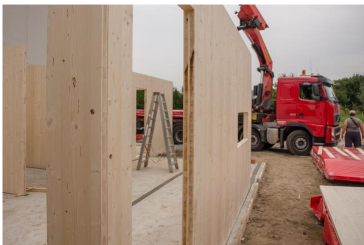
Obrázek 6: Stavba domu z CLT panelů
