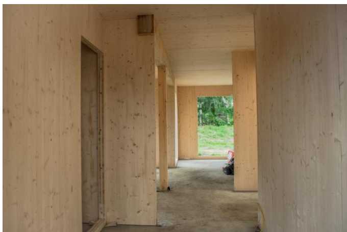
Obrázek 7: Hrubá stavba z CLT panelů
