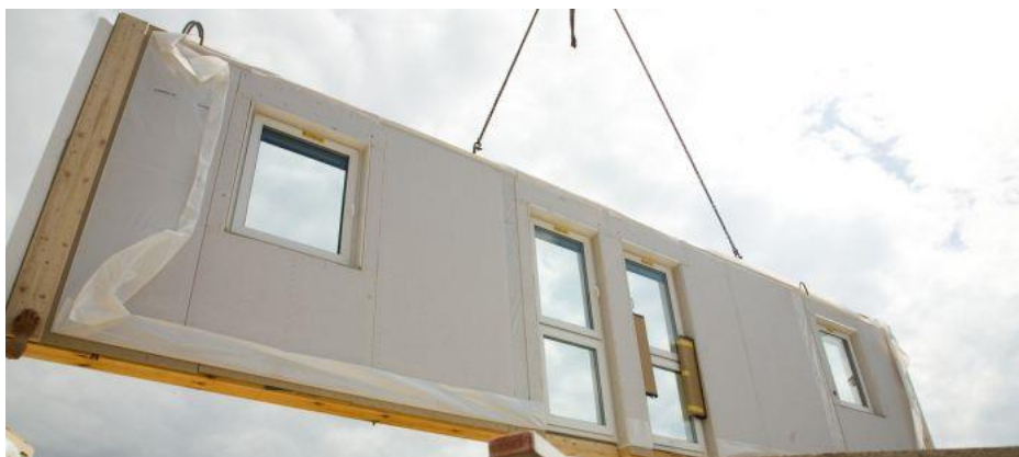
Obrázek 8: Usazení panelových dílců na stavbě. (Zdroj: https://www.drevostavitel.cz/clanek/drevostavba-za-3-tydny )
