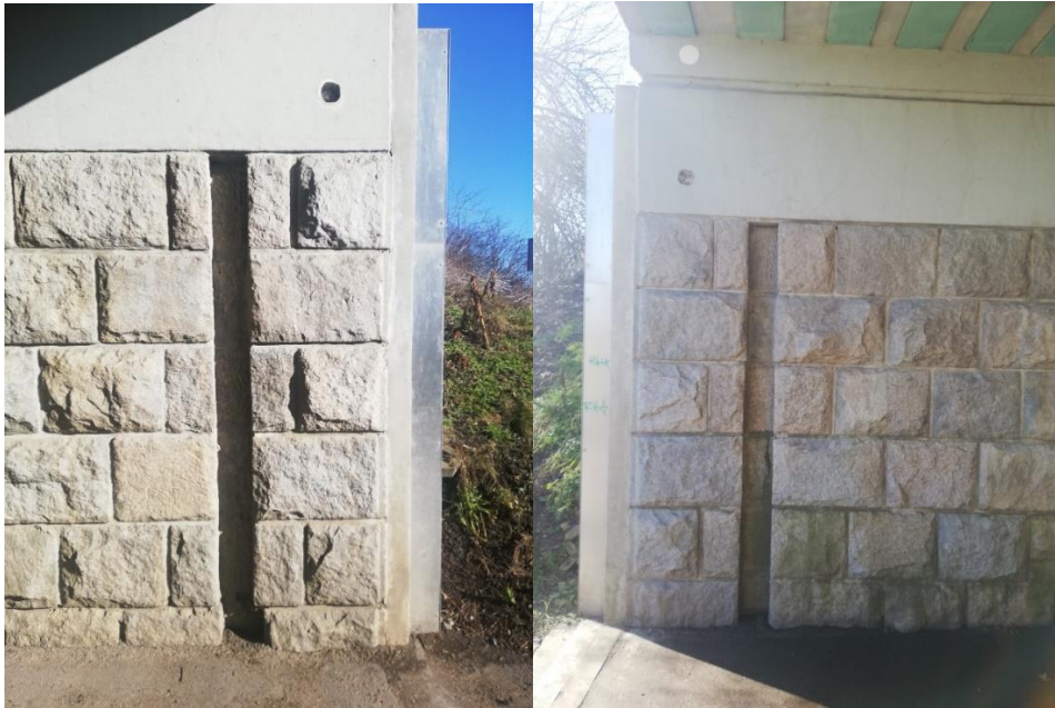
Obr. č. 7, 8 – Drážky pro umístění fošen (bývalé protipovodňové opatření); zdroj: autorka
