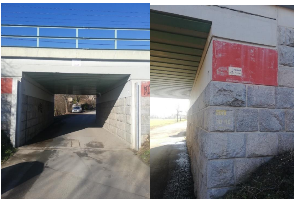
Obr. č. 5,6 – Historické zmapování výšky hladiny v samotné konstrukci viaduktu; zdroj: autorka
