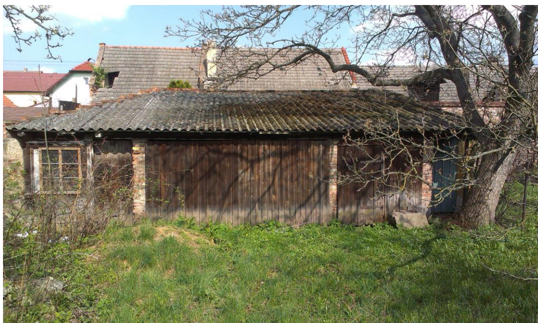
Obr. 21: Východní pohled na kůlnu (vlastní foto)
