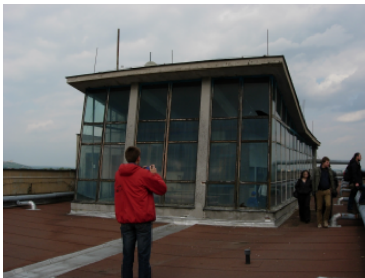
23/ Pavilon baru na střeše Pozemních staveb Pardubice, dnes T-String, Masarykovo náměstí 1484, Karel Crkal, 1961-1966
