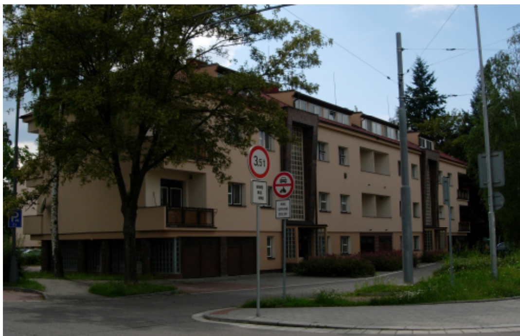
8/ Bytový dům, Dašická 1160-1161, Karel Řepa, 1947-1948
