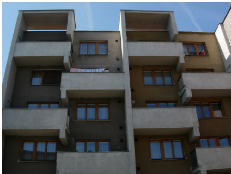
47/ Bytový dům, Na Třísle 42-43, detail fasády
