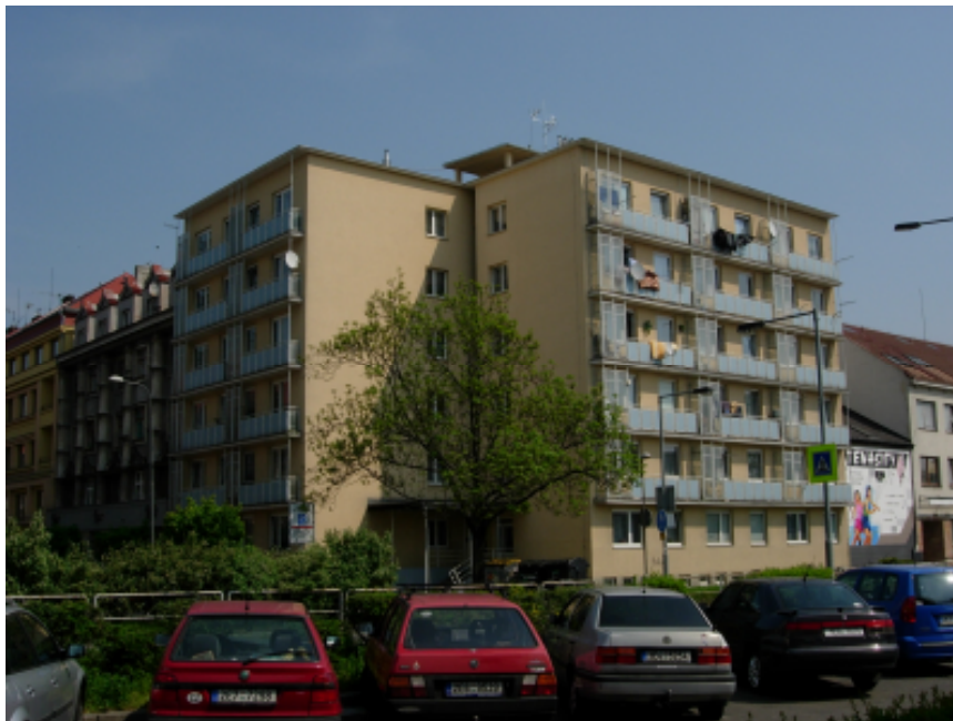
28/ Bytový skleněný dům , Havlíčkova 84, Karel Horníček, 1961-1962
