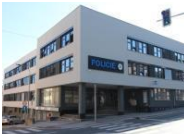
Obrázek 1: Budova obvodního oddělení policie Třebíč
