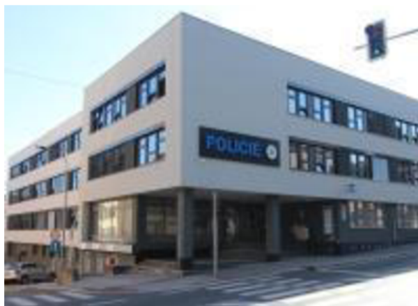
Obrázek 1: Budova obvodního oddělení policie Třebíč
