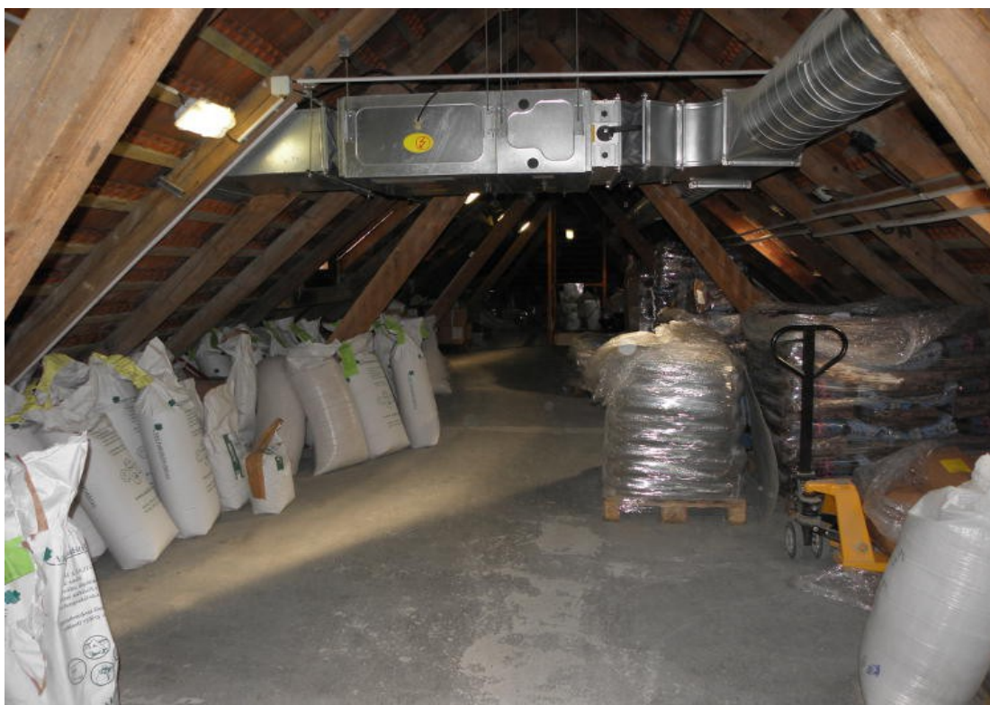
Obr. 35 Hlavní sklad krmiv a pohled na větrací potrubí (foto: Ondřej Kotek)
