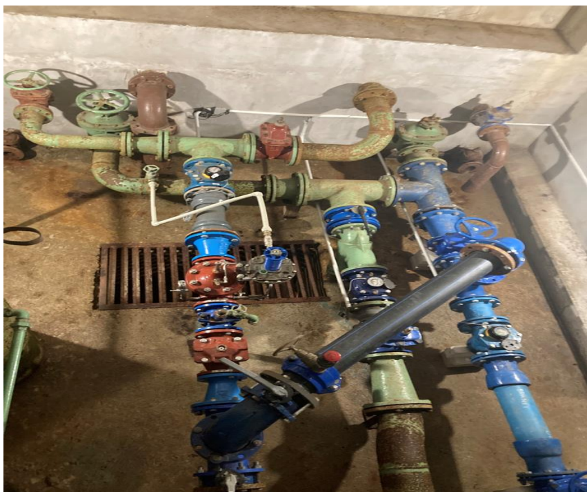
Obr. 1. 11 Armaturní komora vodojemu
