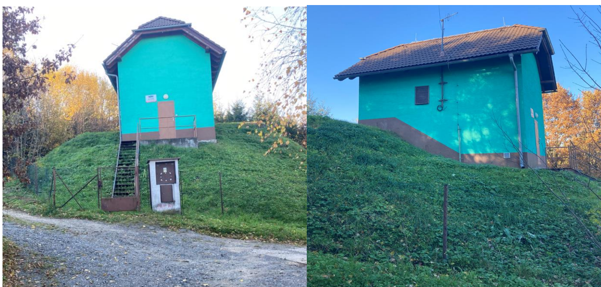
Obr. 1. 9 Čelní pohled na VDJ (vlevo) - Boční pohled na VDJ (vpravo)
