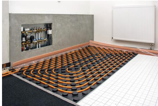
Obr. 2.14 Teplovodní podlahové vytápění [54]
