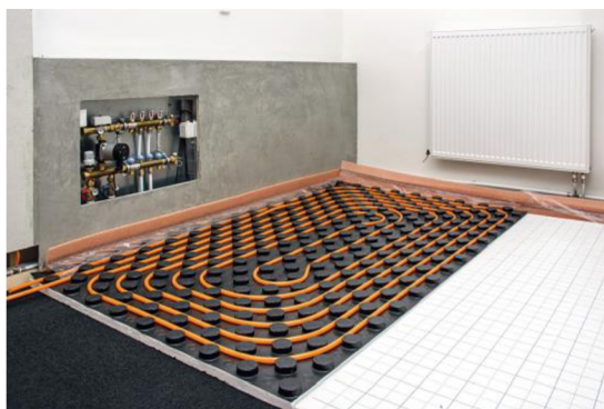
Obr. 2.14 Teplovodní podlahové vytápění [54]
