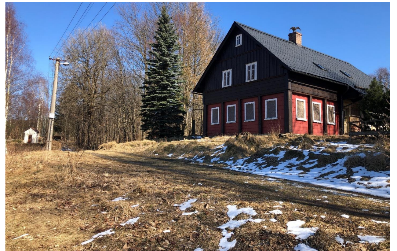
Obrázek 40: Aktuální pohled na opravený dům, 2022 (zdroj: autor)
