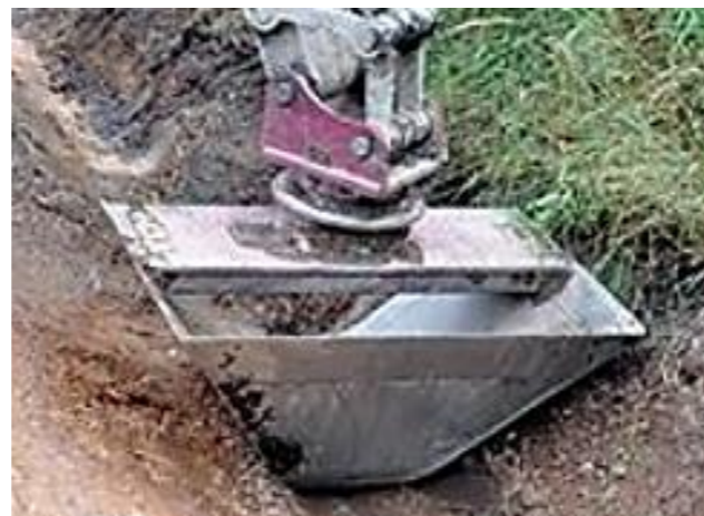
Obrázek 17: Čištění podélného odtoku vody. (zdroj: online 31 )
