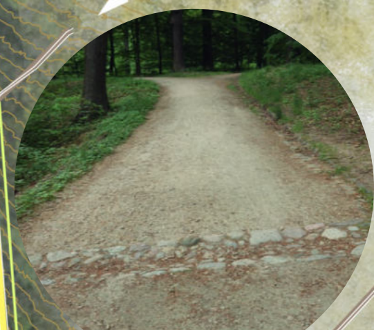
Obrázek 74: Lesní stezky - příčný kamenný žlábek odvádí přebytečnou vodu do navazujícího porostu Zdroj: Zlatuška 2015
