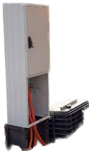
Obrázek 5: Technologický pilíř se zemní komorou (zdroj: Autor)
