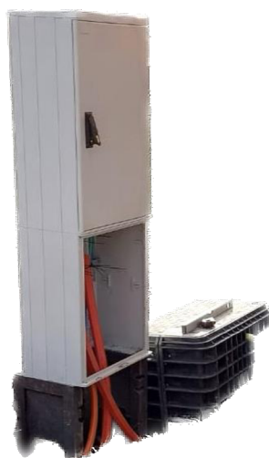
Obrázek 5: Technologický pilíř se zemi komorou (zdroj: Autor)
