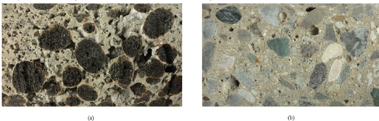
Obr. 4 Průřezy vzorků matečního betonu:
