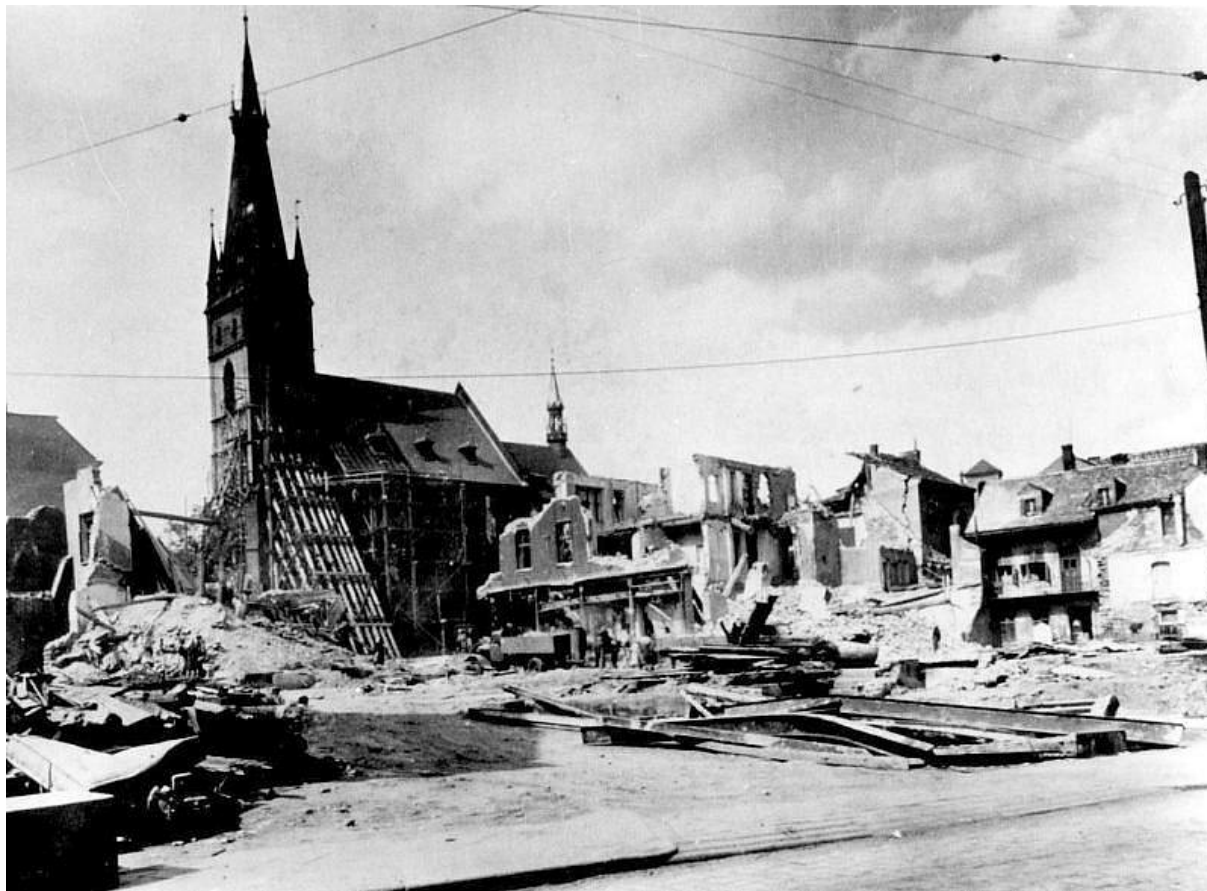
Obr. 4 Podepření kostela Nanebevzetí panny Marie po bombardování v roce 1945 (zdroj: Archiv města Ústí nad Labem)
