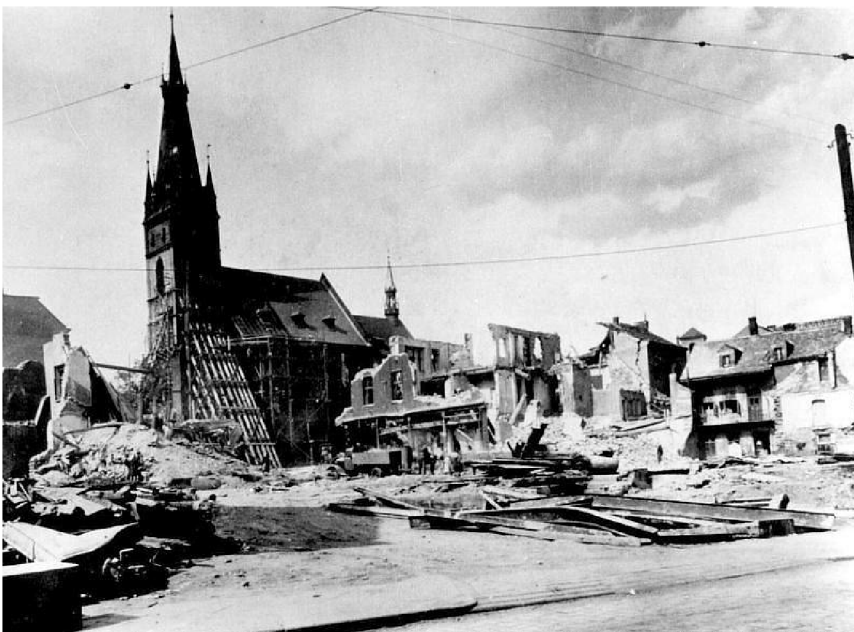
Obr. 4 Podepření kostela Nanebevzetí panny Marie po bombardování v roce 1945 (zdroj: Archiv města Ústí nad Labem)
