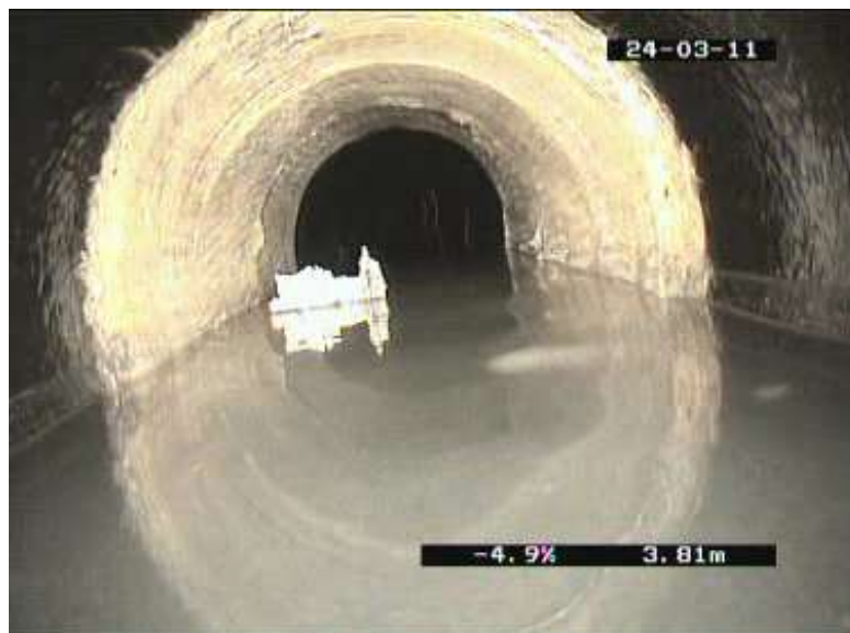
Foto č. 16 – vyložkování pryskyřicí nasyceným rukávcem.
