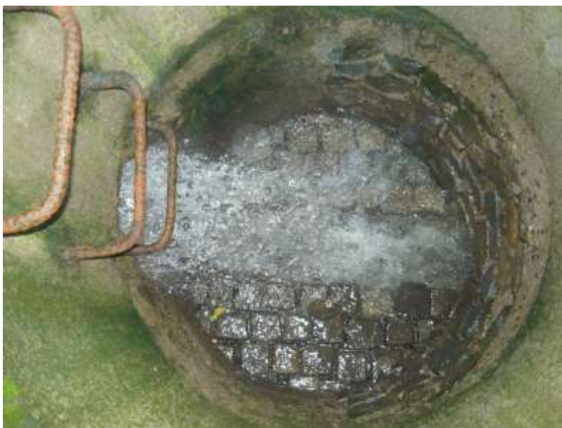
Foto č. 8 - Průtok splaškové a balastní vody spádlišťovou šachtou.
