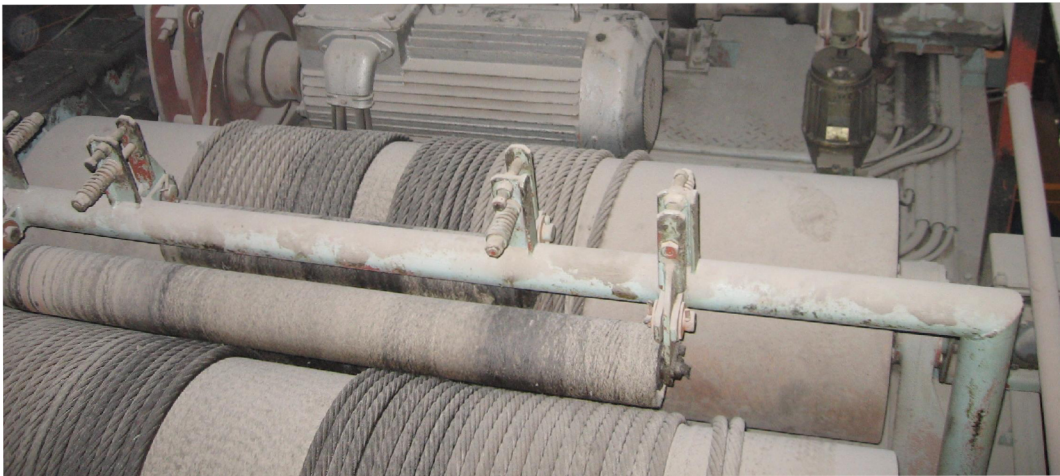
Obr. 2.5: Původní konstrukce lanových bubnů
