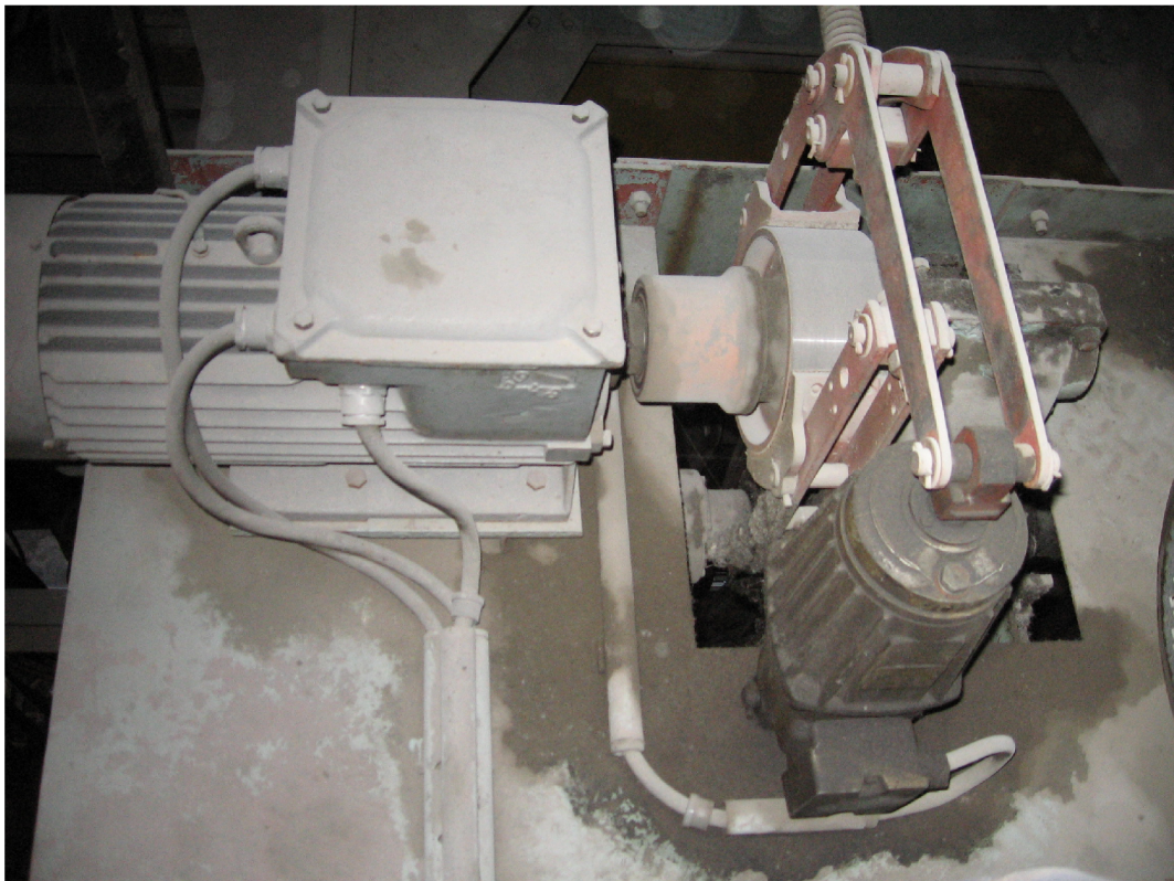
Obr. 2.1: Původní pohon pojezdu kočky
