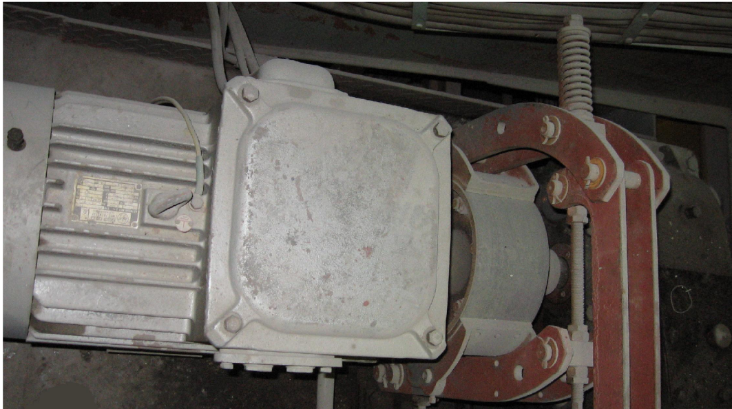
Obr. 2.2: Původní pohon pojezdu mostu
