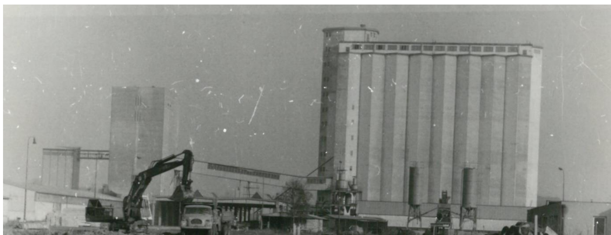
Obrázek 1 – Betonové silo 21kt, Kolín 1968
