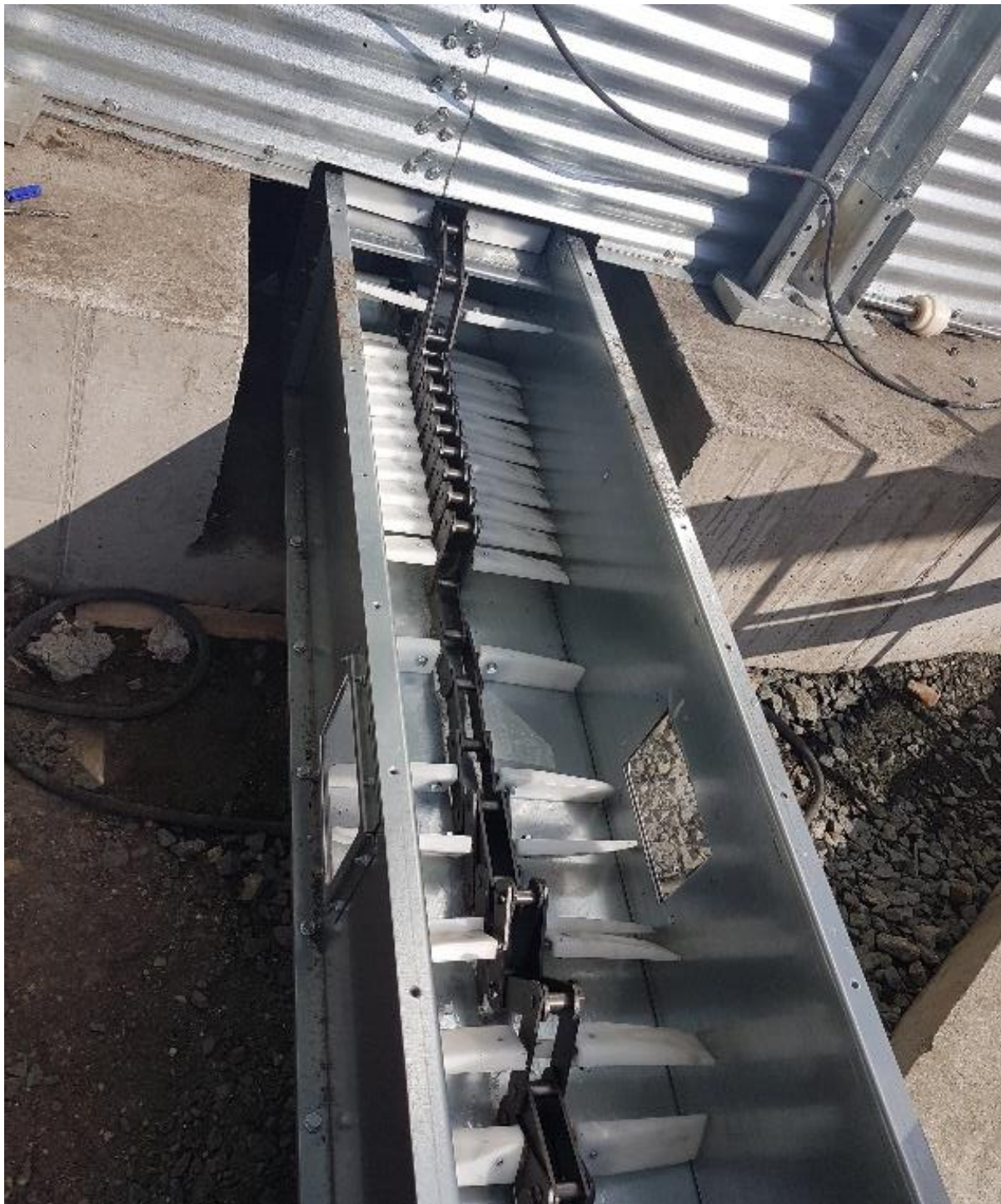
Obrázek 10 – Montáž redleru
