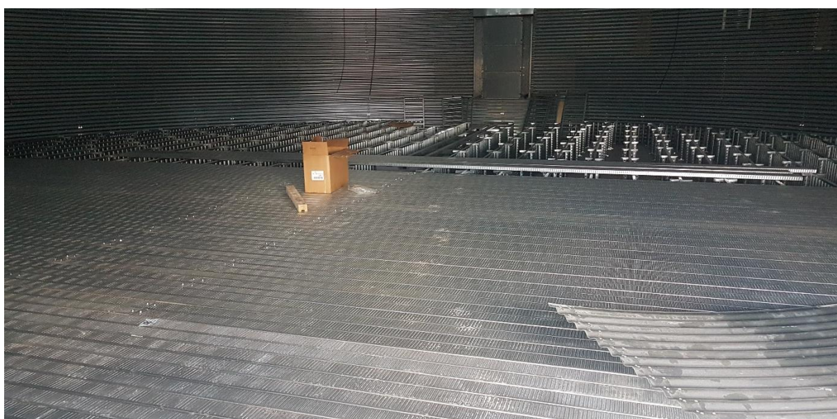
Obrázek 5 – Montáž celoprovzdušněné podlahy, Křinec 2018
