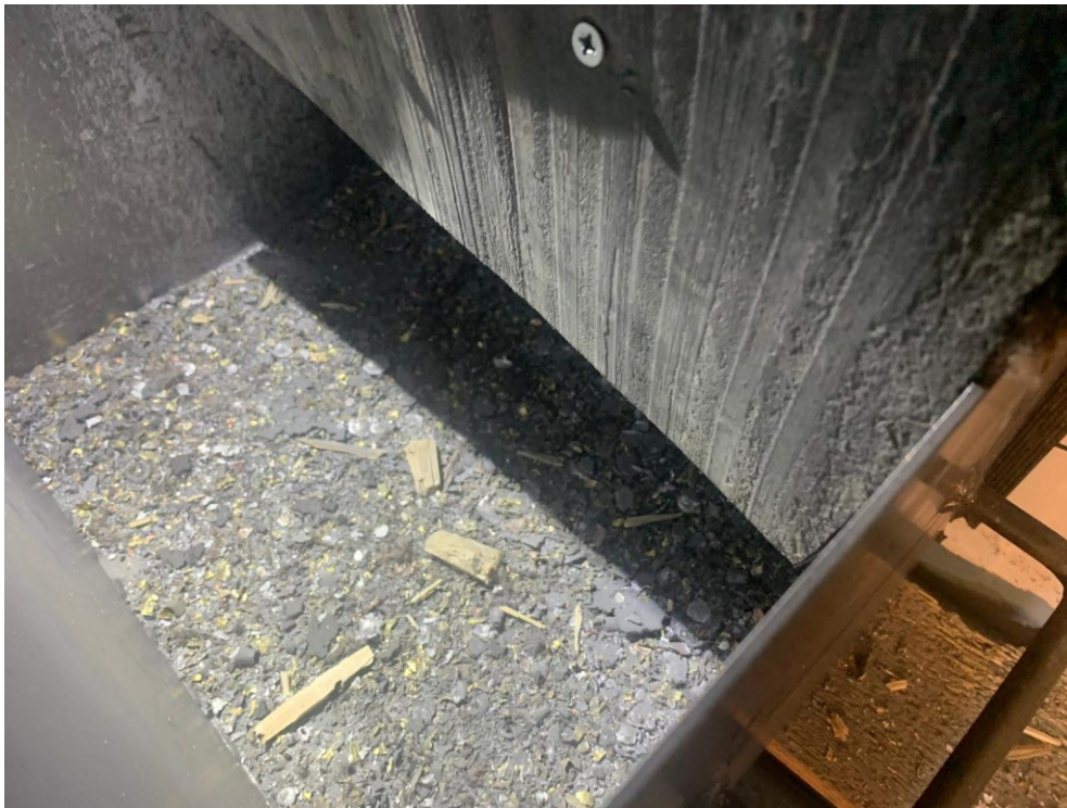
Obr. 2.7 Odpadová nádova destruktčního lapače [zdroj: vlastní provedení]
