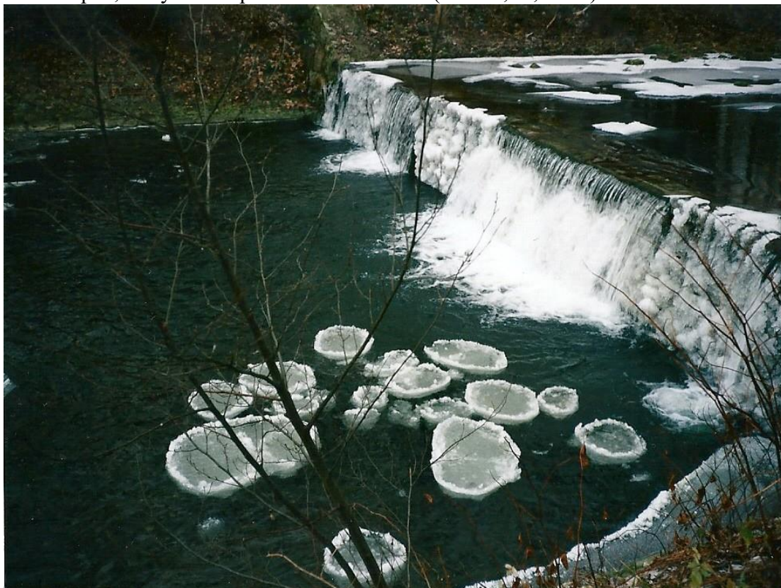
12 6. stupeň, který odolal povodni v roce 1997 (Průcha, V., 1998)
