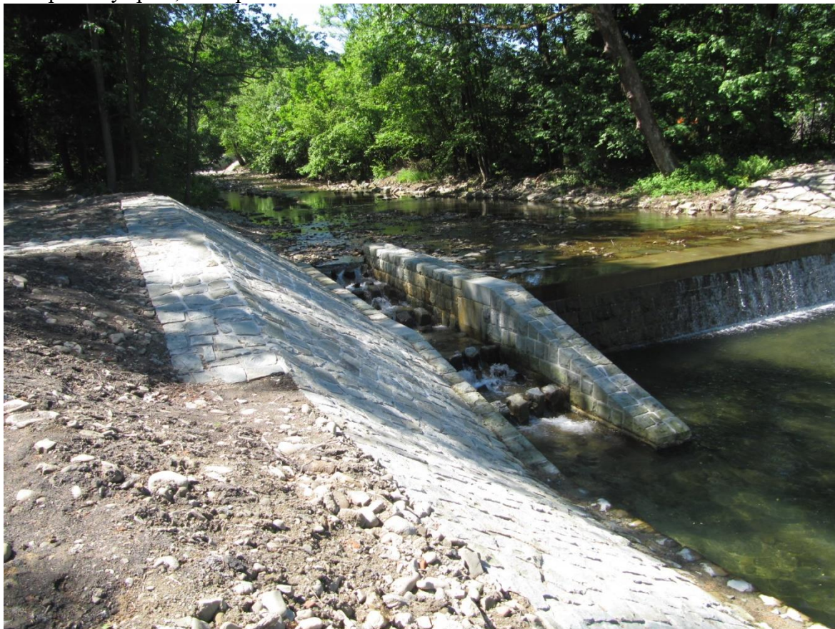
76 Opravený splav, 6. stupeň
