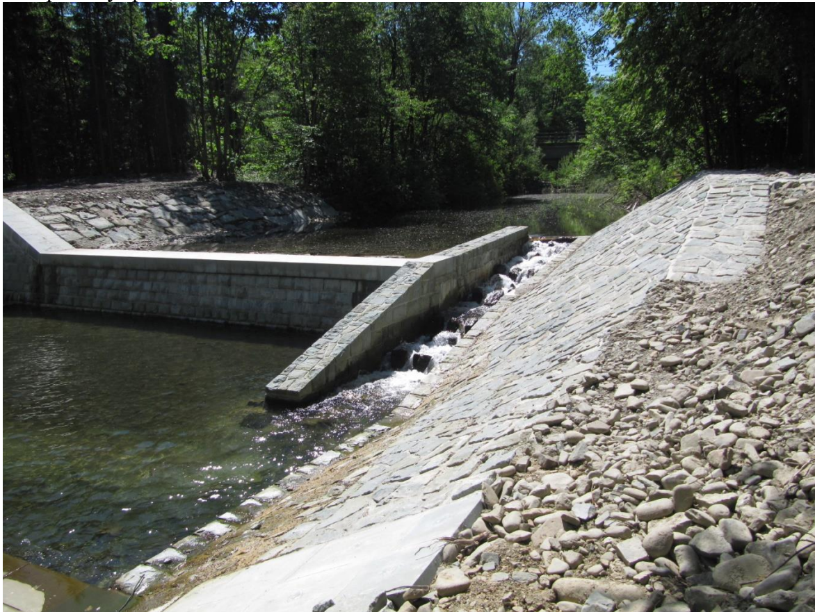
82 Opravený splav, 9. stupeň
