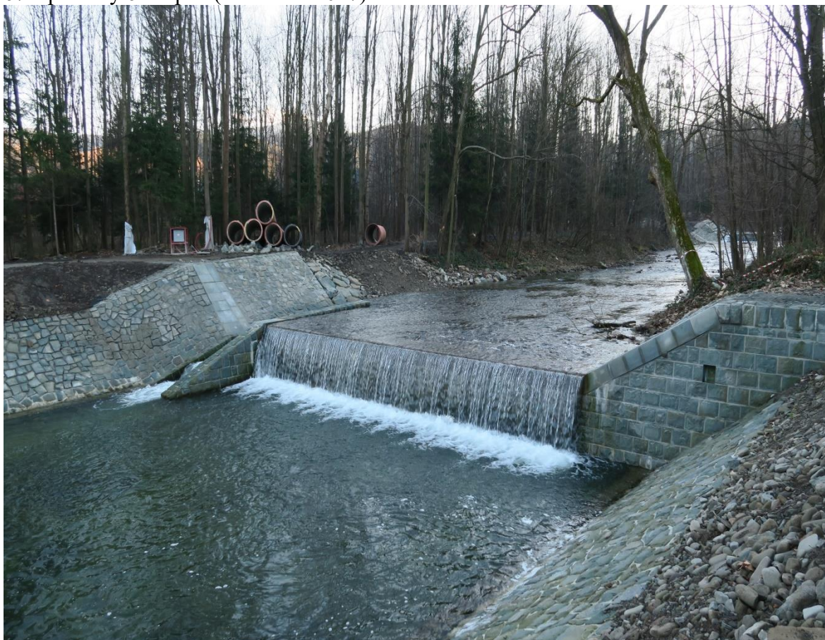
67 Opravený 6. stupeň (V. Průcha 2017)
