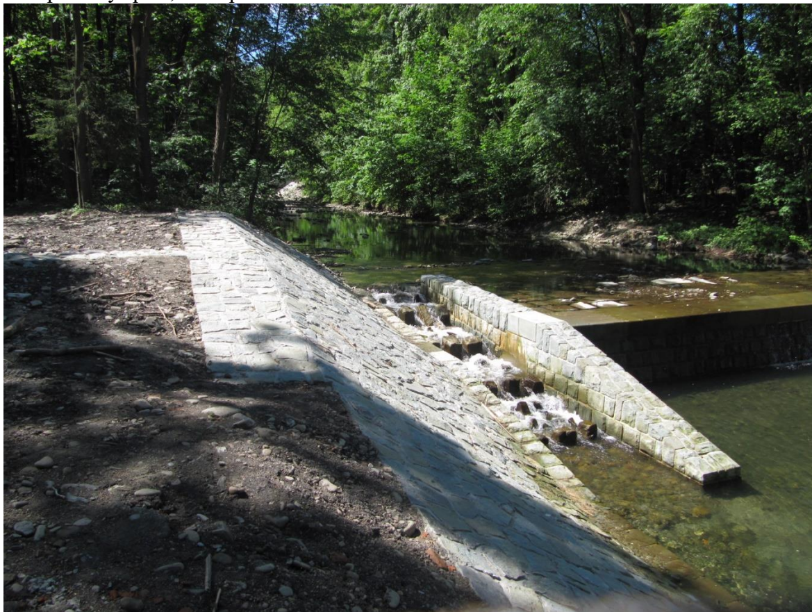
78 Opravený splav, 7. stupeň
