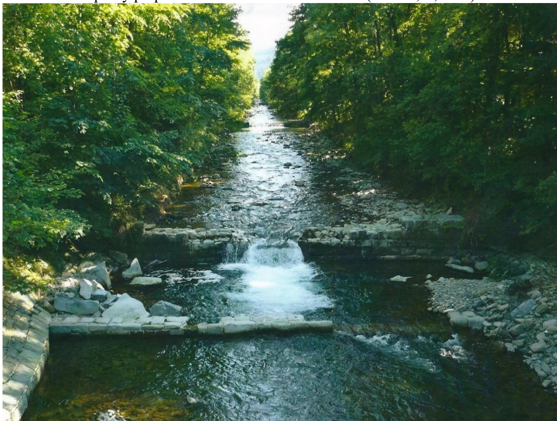
27 Narušené splavy po povodních v letech 1997 a 2007 (Průcha, V., 2008)
