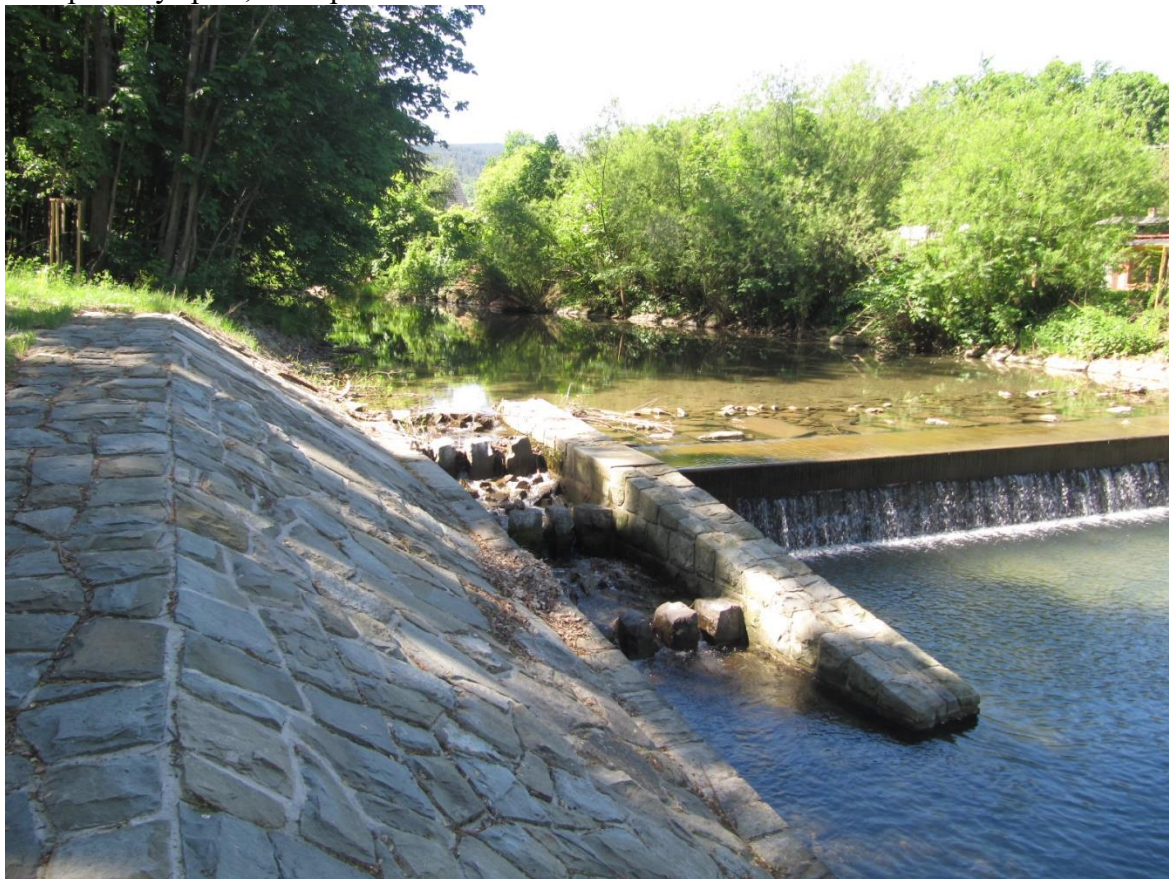
68 Opravený splav, 2. stupeň
