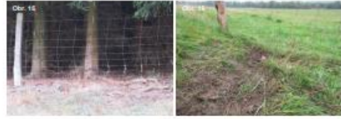
Obr. 15: Dva oplocení, stádo místo – částečné postavení a uzavřený plot, pro který rozhodl policista (Foto: P. Kune). Obr. 16: Detail oplocení a místa podhrabání (Foto: P. Lupaš)
