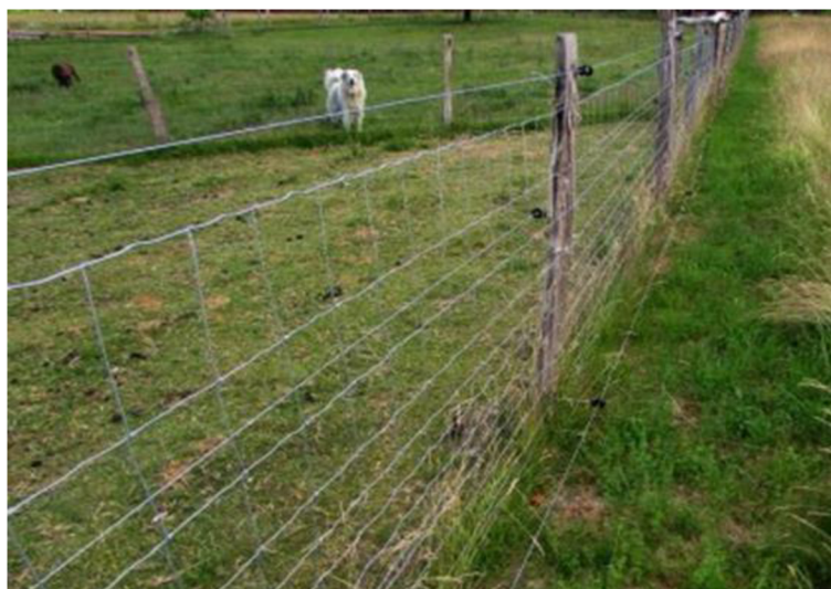
Obrázek 13 Pevné oplocení a předsunutý el. vodič - ochrana proti podhrabání, Zdroj AOPK 2023
