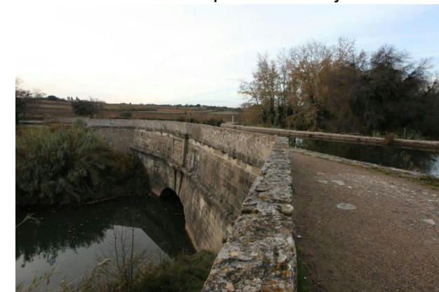
Obr. 9: Akvadukt u Répudre
