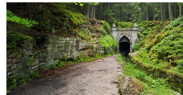
Obr. 26: Schwarzenberský kanál horní portál tunelu u Jeleních Vrchů
