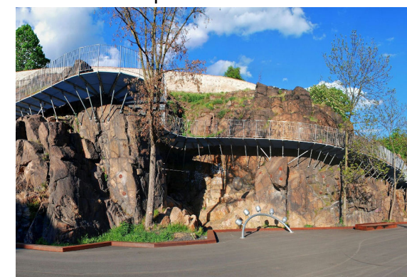
Obr. 40: Nábřeží Maxipsa Fíka-cyklistická lávka vyvěšená z rulového masivu
