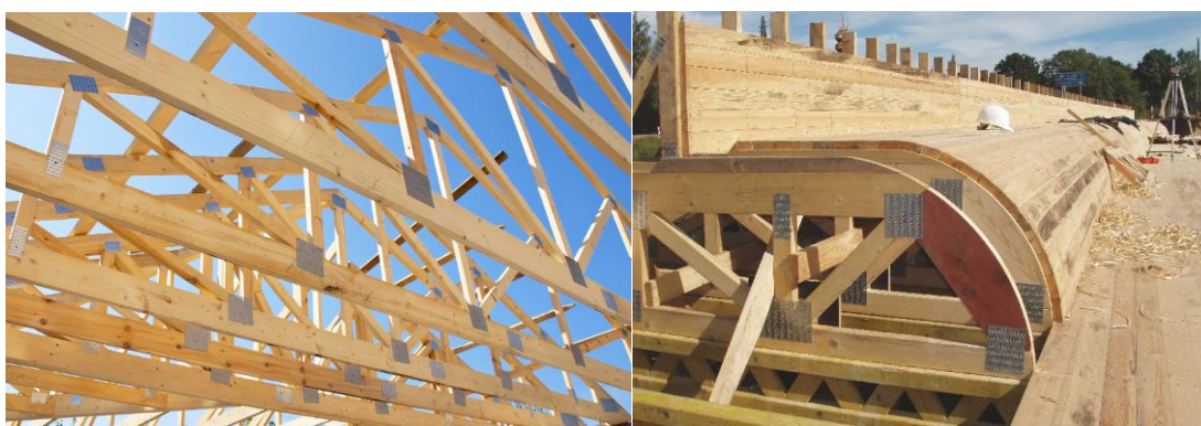
Obr. 23 Příklady použití styčnickových desek (Kasper cz s.r.o. 2020)
