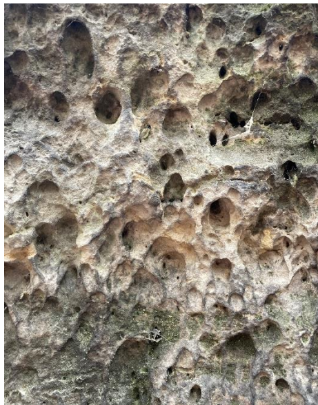
Voštiny na skalním průchodu
