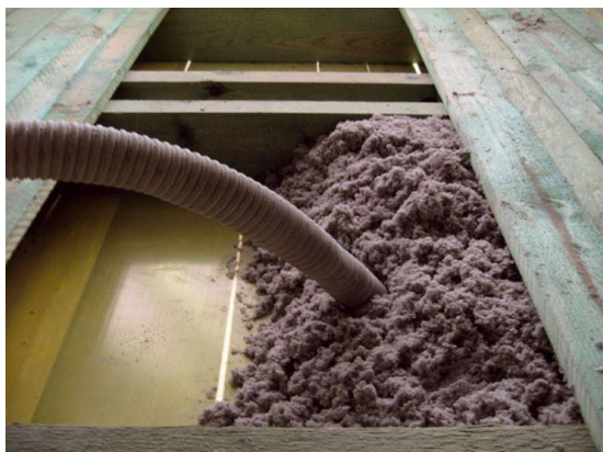
Obr. 1.11 Aplikácia celulózovej izolácie [17]
