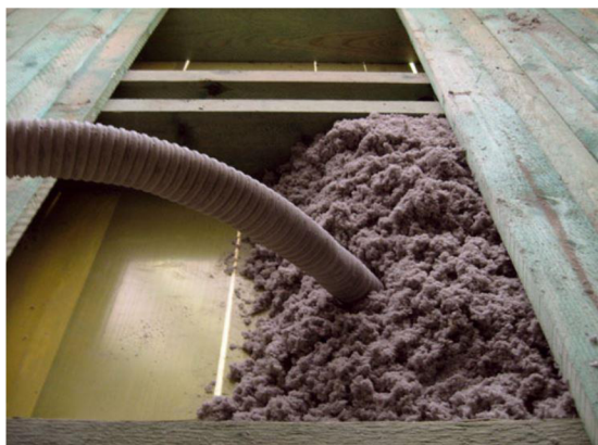
Obr. 1.11 Aplikácia celulózovej izolácie [17]
